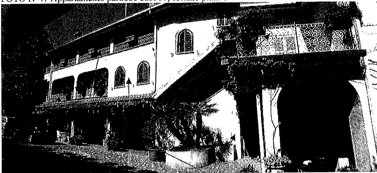
FOTO N°47 Appartamento part.686 sub507, esterno piani 1°-2°-3° lato est:
